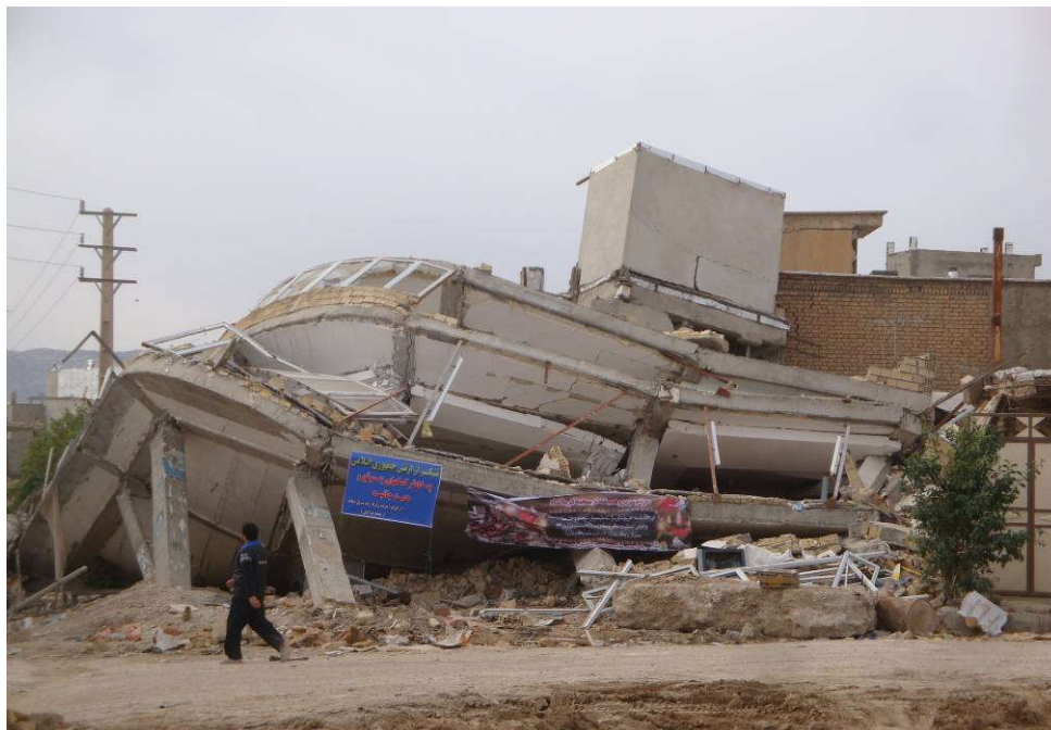
مکان و کیفیت نا مناسب ساخت و ساز تخریب شدید برخی سازه ها را به همراه داشته است
